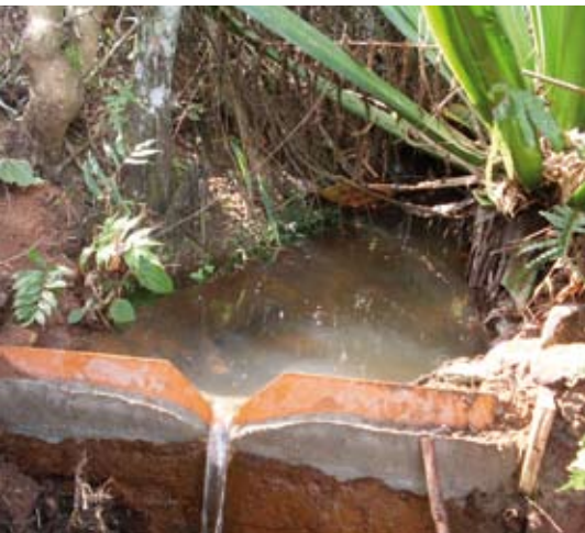
Vertedero improvisado para la medición del flujo en un pequeño embalse para captar el agua dentro de una de las propiedades estudiadas
