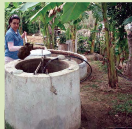
Alimentando el biodigestor
