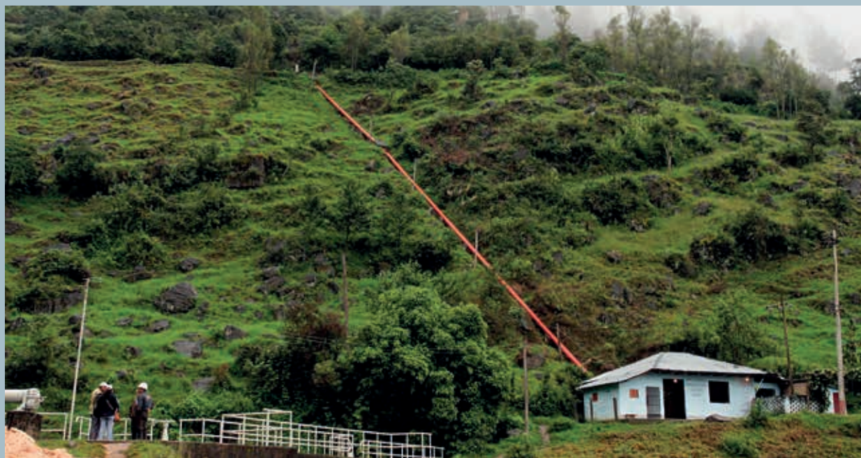
Microcentral en el distrito de Cochán, Cajamarca, Perú, construida en 1995. Logró beneficiar a 150 familias (actualmente más de 300 familias). 📍 Malu Cabellos, Soluciones Prácticas
