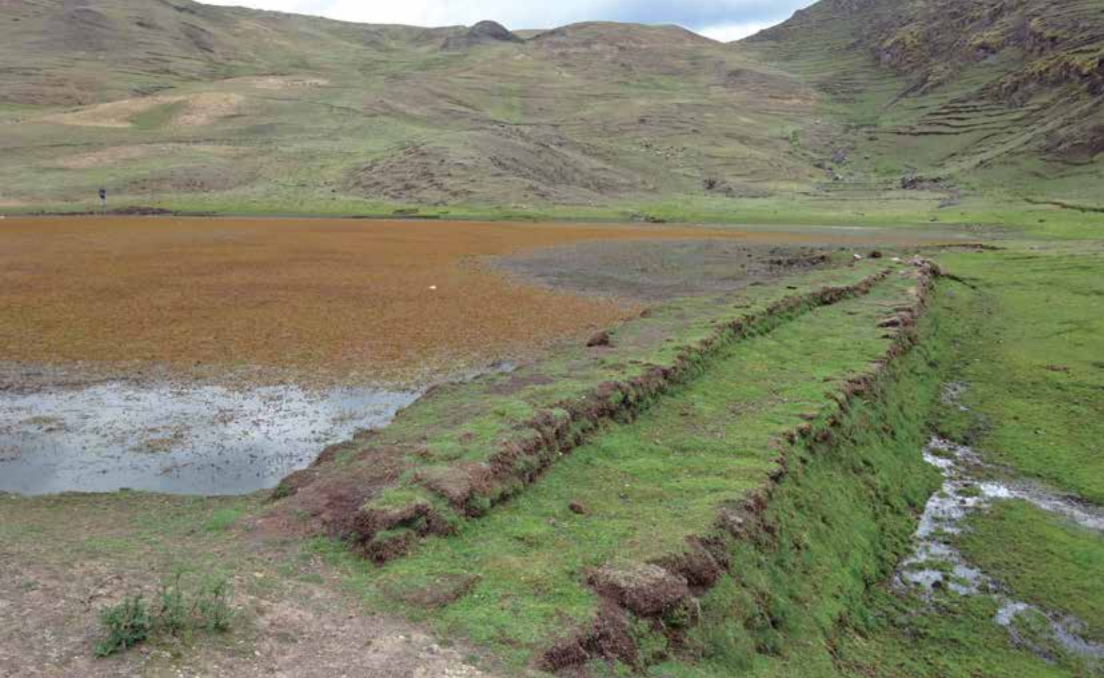
Retención de agua en una q'ocha para favorecer la humedad del subsuelo en zonas aledañas. Se ha construido un dique sencillo de champas (terrones) con la finalidad de infiltrar el agua desde el fondo hacia zonas aledañas para el mejoramiento de la cobertura vegetal. Microcuenca Chuecamayo, San Salvador, Calca, Perú. Jan Hendriks
