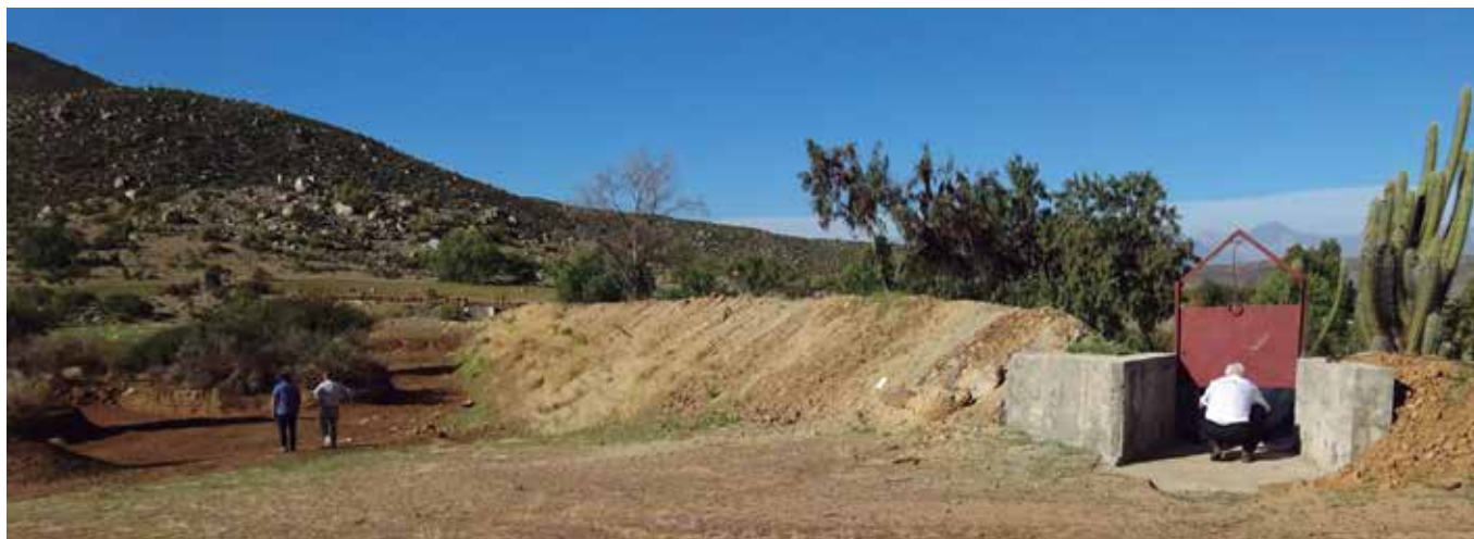
Dique de tierra de regular tamaño, que aprovecha una leve concavidad topográfica en ladera, para retener y hacer infiltrar al subsuelo considerables cantidades de aguas lluvias. (Predio familiar en el sector Chañar, comuna de Combarbalá, Región de Coquimbo, Chile). ■ Jan Hendriks
